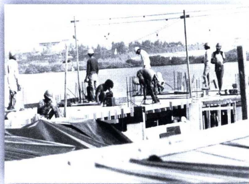
Fevereiro de 1977: operários trabalham em ritmo acelerado para concluir a obra no prazo previsto. Abaixo, dois destaques do projeto: as construções do castelo d'água e do teto, em copas, dos salões. A integração da estética arquitetônica com o concreto armado.
